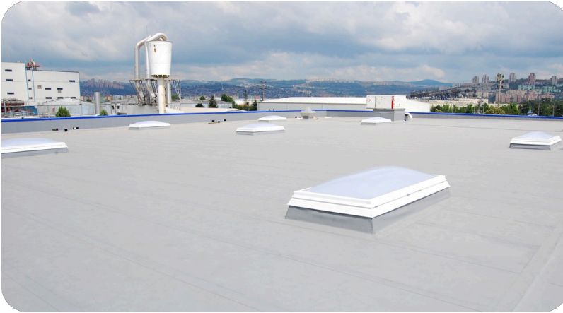
Tek kat membran altında PIRBOARD, geniş açıklıklı sanayi çatısı
