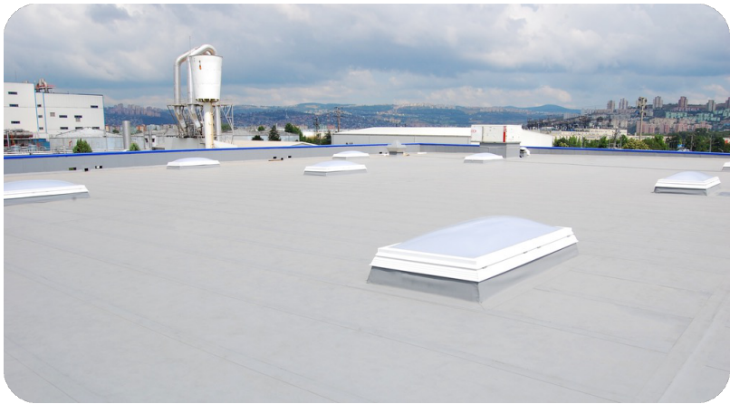
PIRBOARD под однослойной мембраной, промышленная кровля большого пролёта
