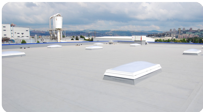
PIRBOARD sub o membrană monostrat, acoperiș industrial de deschidere mare
